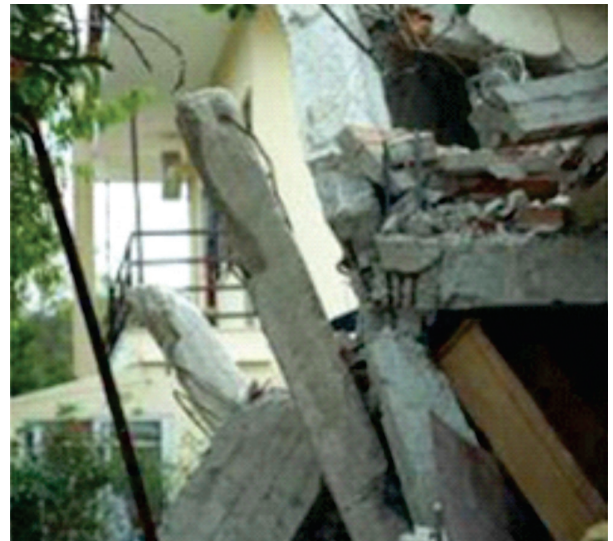
Figura 4.3 – Colapso devido à rigidez inadequada dos nós de pórtico (Dantas, 2013).
