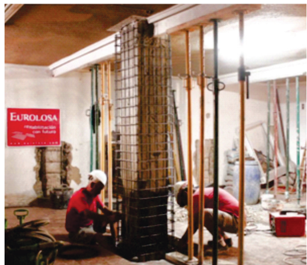
Figura 5.3 – Encamisamento de pilar.
