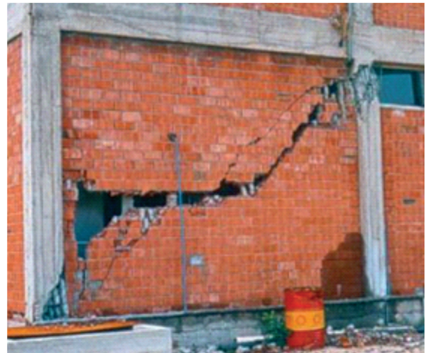
Figura 4.3 – Colapso devido à rigidez inadequada dos nós de pórtico (Dantas, 2013).
