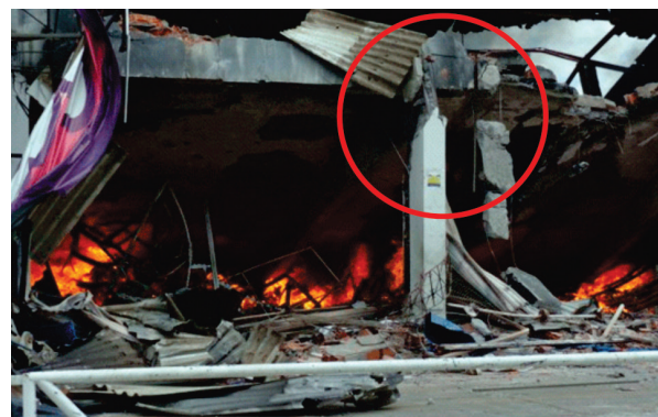
Figura 4.11 – Movimento devido à dilatação estrutural, rompimento de viga e nó de pórtico.
