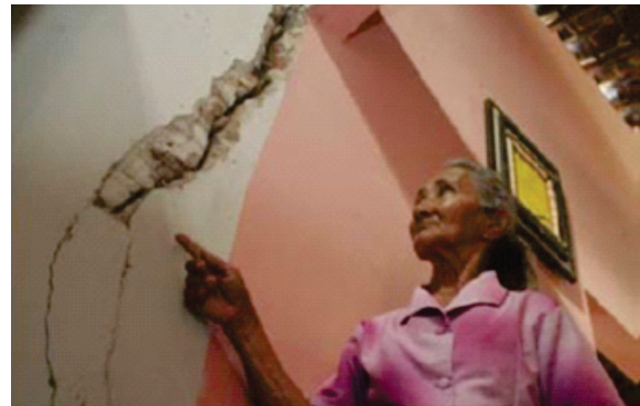
Figura 3.1 – Consequências das solicitações sísmicas em uma residência localizada em Poço Branco, RN (Dantas, 2013).
