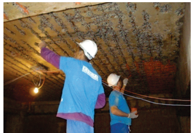
Figura 5.5 – Aplicação de produto antioxidante para proteção das armaduras expostas, antes da aplicação do concreto projetado.
